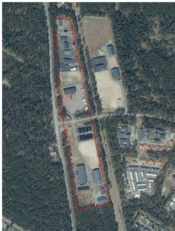
Planområdet med kv. Misteln i norr och kv. Martornen i söder. Källa: Kristianstads kommun
