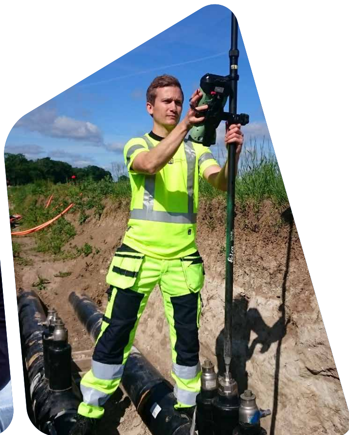
Inmätning av fjärrvärmeledningar på Näsby.
