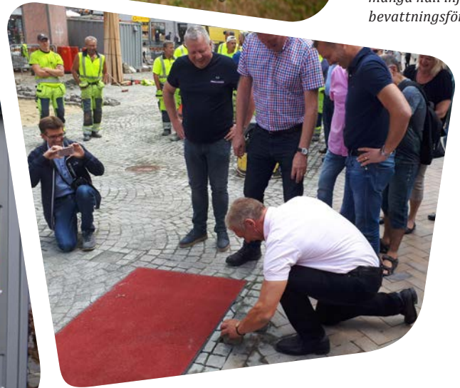
Västra Storgatan fick nya VA-, fjärrkyle- och fiberledningar, markvärme, och möblering. Det framgångsrika projektet genomfördes på rekordtid, i tät dialog med verksamheterna i staden.
