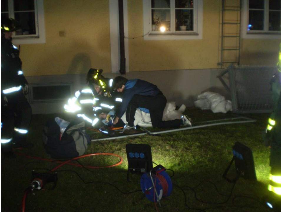
2010-06-10 skadades fem personer när en utrymningsbalkong rasade. Räddningstjänst- och ambulanspersonal samarbetade med skadelindrande åtgärder.
